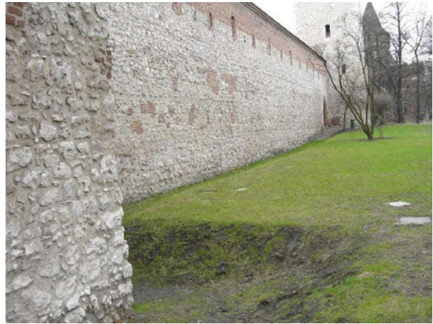
Il. 8. Kraków, mur obronny z bramą Floriańską, widok od północnego wschodu, (fot. B. Krasnowolski).
