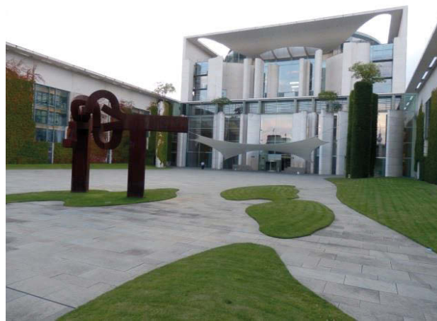
Il. 9. Dzielnica rządowa nad Szprewą, Urząd Kanclerski, projekt: Axel Schultes i Charlotte Frank, (fot. J. Barnaś).
