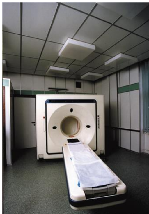
Il.9. Pomieszczenie tomografu komputerowego, zrealizowane w ramach modernizacji i rozbudowy Budynku Głównego Szpitala im. Gabriela Narutowicza w Krakowie. Realizacja z roku 1999 według projektu zespołu: Andrzej Walkowski, Dariusz Ociepa, Bartłomiej Rados (z materiałów archiwalnych biura projektów Studio AW).
