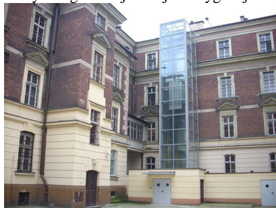
Il.2. Dobudowany zewnętrzny dźwig towarowo-osobowy szpitala Aresztu Śledczego w Krakowie przy ul. Montelupich 7. Dźwig łączy oddziały: chirurgii na 1. piętrze, interny na 2. i psychiatrii na 3. Realizacja z lat 2004-2005 według projektu zespołu: Andrzej Walkowski, Dariusz Ociepa, Bartłomiej Rados. Obudowa części przyziemia została podyktowana koniecznością sprostania procedurom więziennym (z materiałów archiwalnych biura projektów Studio AW).
