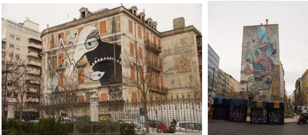
Ryc. 7. Przykłady murali jako sztuki poprawiającej wygląd elewacji obiektów przeznaczonych do remontu lub rozbiórki, Lizbona, Fot. N. Przesmycka.
