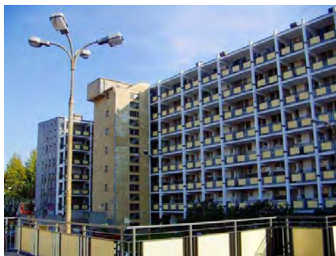
Ryc. 1. Widok na segment galeriowca z Osiedla Młodych w Warszawie [2] Fig. 1. Segment of a gallery-access block of flats, Osiedle Młodych, Warsaw [2]
