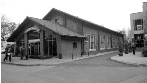
Ryc. 1. Politechnika Krakowska - Kotłownia.
