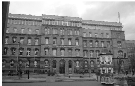
Ryc. 2. Politechnika Krakowska - budynek główny.
